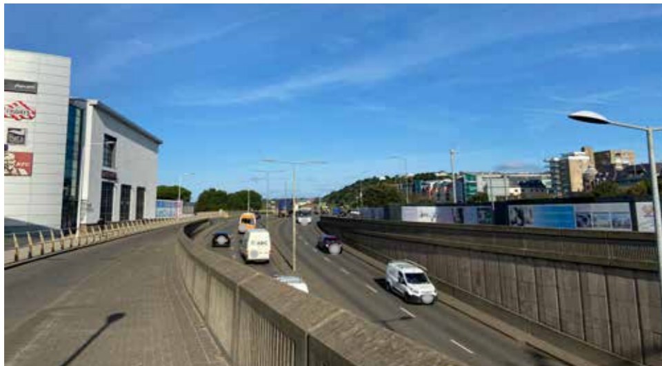
Figure 2.5 La Route de la Libération underpass (2)
